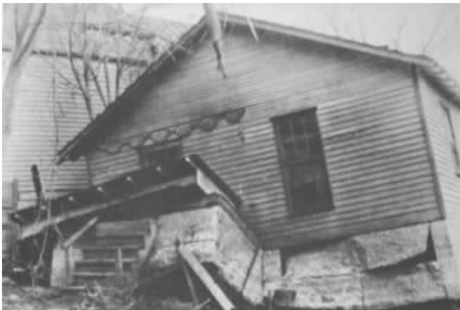
◆《开垦平原的犁》中被推倒的房屋。
